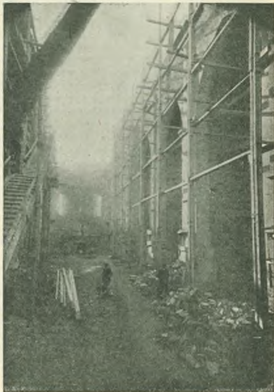
FIRENZE — Santuario della S. Famiglia La nave centrale.
